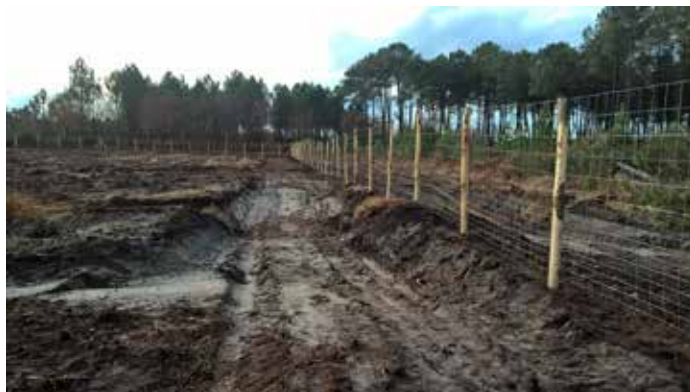
Le site est clôturé
